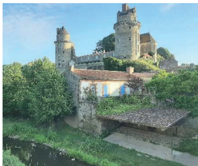
Lavoir avant réhabilitation
